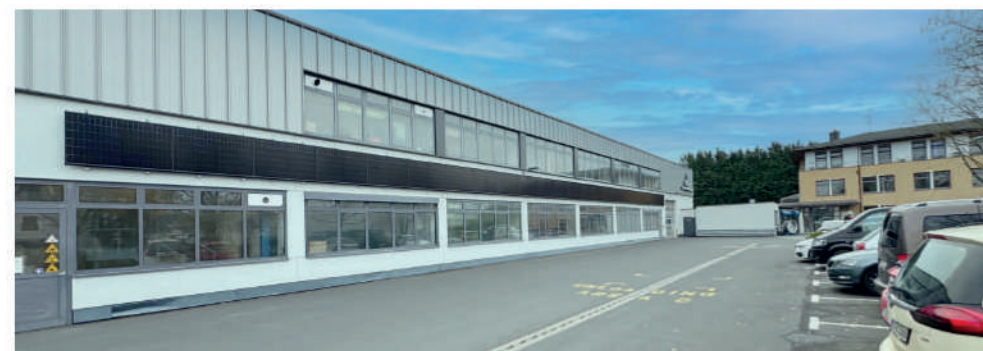
Photovoltaikanlage bei OHL Gutermuth in Altenstadt
